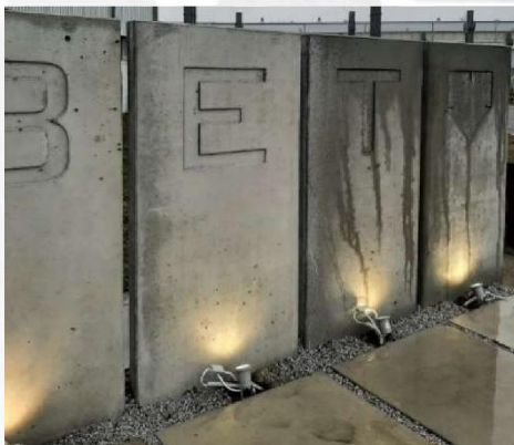
Abb. 5. Links: Mauern mit LOVBET Imprägnierung, rechts: ohne Imprägnierung
