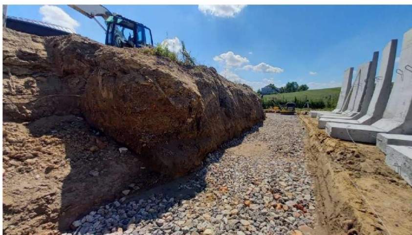
Abb. 3b. Unterbauschicht aus Zuschlagstoff
