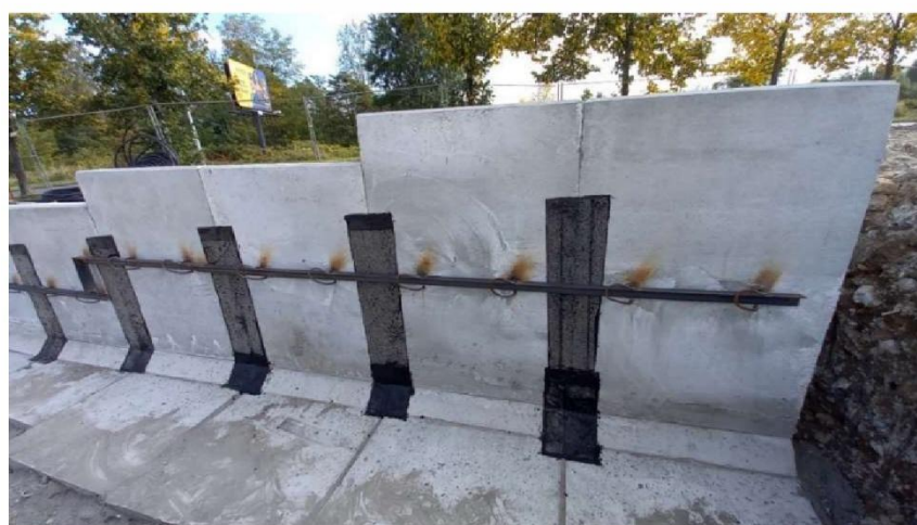
Abb. 4. Streifen aus Abdichtungsmaterial an der Verbindung der Stützmauern auf der Innenseite.
