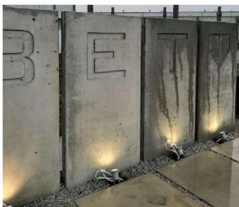
Abb. 9. Links: Mauern mit Imprägnierung, rechts: ohne Imprägnierung
