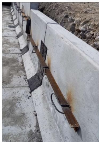
Abb. 6a. Sicherung gegen den Höhenversatz durch Verbindung der Stützmauern mittels Bewehrungsstäben mit einem Durchmesser von \varnothing 16 mm oder eines Winkels 50x50x5 – vor dem Auftragen des Korrosionsschutzmittels.
