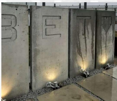
Abb. 1. Links: Mauern mit LOVBET Imprägnierung, rechts: ohne Imprägnierung
