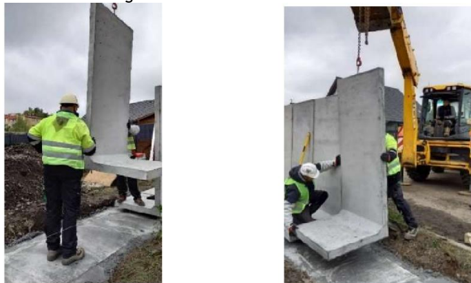
Abb. 1. Beginn der Verlegung der Zaunmauern auf dem vorbereiteten Untergrund.
