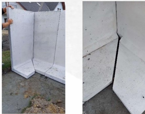
Abb. 5b. Ecken der Zaunmauern
