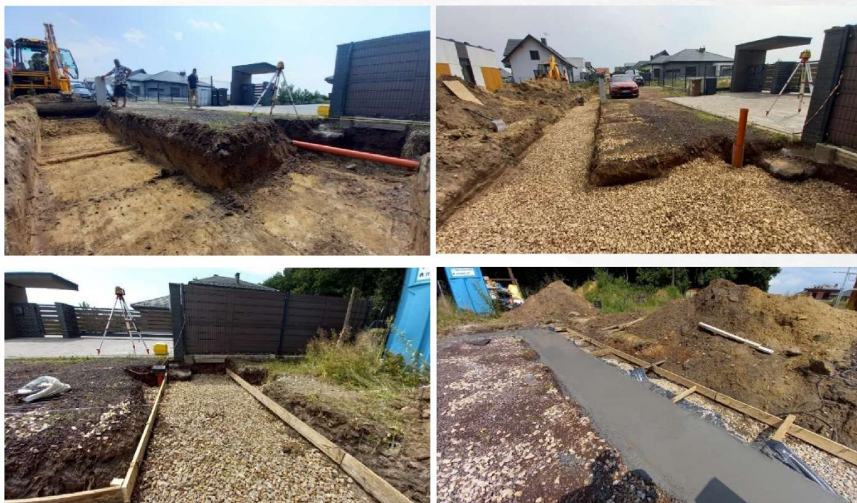
Abb. 2. Die einzelnen Ausführungsphasen des Unterbaus der Zaunmauer (Auskoffnung, Auffüllen mit Zuschlagstoff, Vorbereitung der Schalung, Einbringen des Betons).
