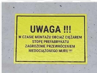
Abb. 4. Aufkleber am Fuß der Zaunmauer, der auf die Notwendigkeit einer Beschwerung hinweist.
